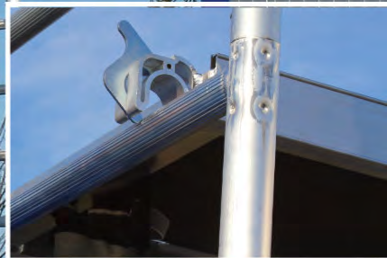
Detailansicht: Belagbühneneinhängung
