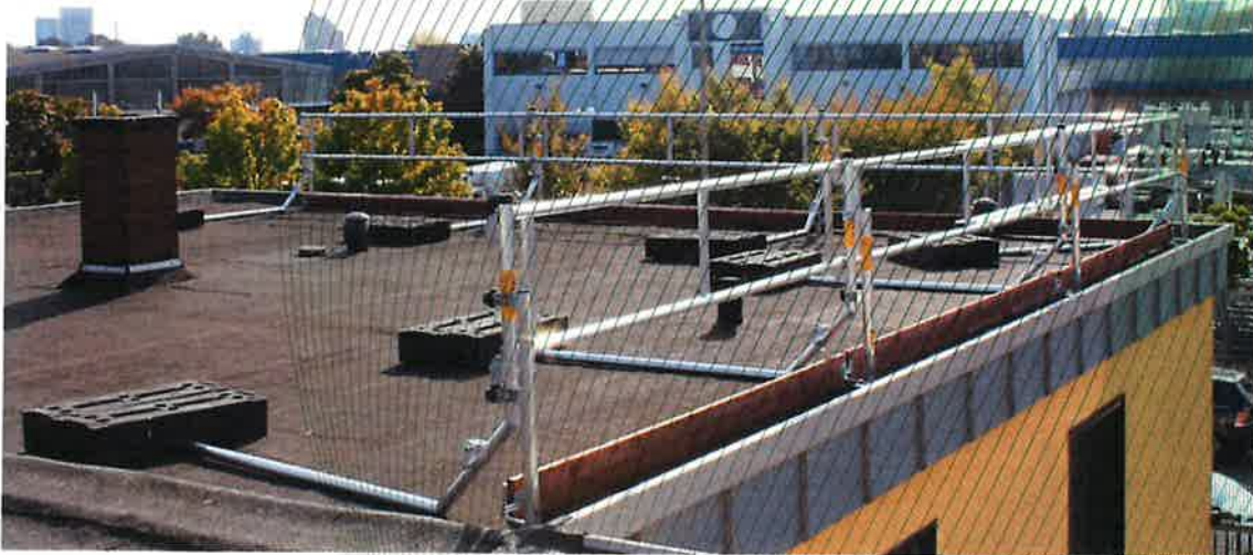
Bild 1: Seitenschutzsystem, Typ: Albert - Flachdachabsturz­sicherung
